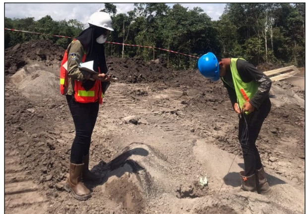
Gambar 1 Pengukuran lubang ledak
